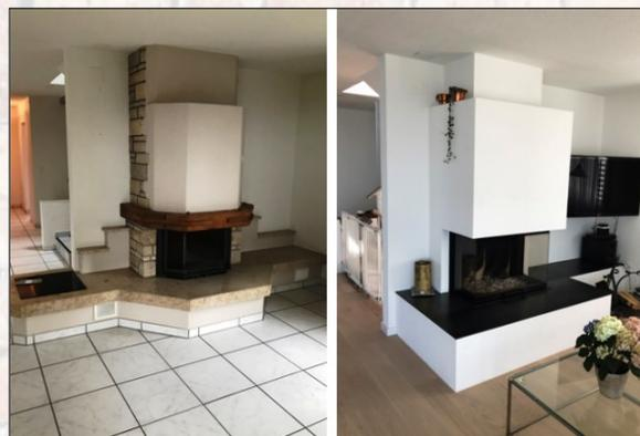
Bei der Cheminéeesanierung wird ein Teil oder auch die ganze bestehende Anlage abgebaut und mit einem Cheminéeinsatz neu aufgebaut. Dabei können Form und Grösse neu bestimmt und optimiert werden. Sollte die „alte“ Cheminéeanlage jedoch gefallen, kann die neue Anlage in alter Form aufgebaut werden. Es ist ebenso möglich, Teile wie Cheminéebänke oder Eichenbalken wieder zu verwenden.
